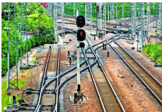
铁路通信系统
